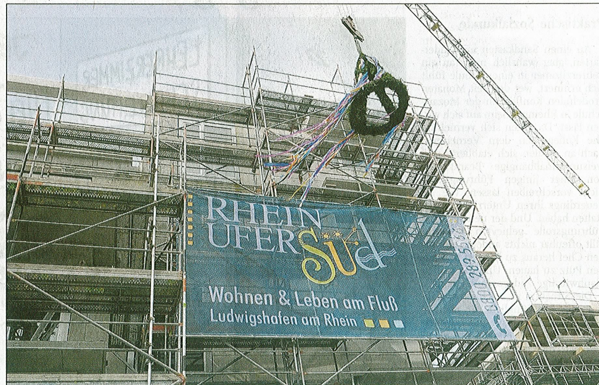
Der Richtkranz weht seit gestern über den Stadtvillen am Rheinufer.
