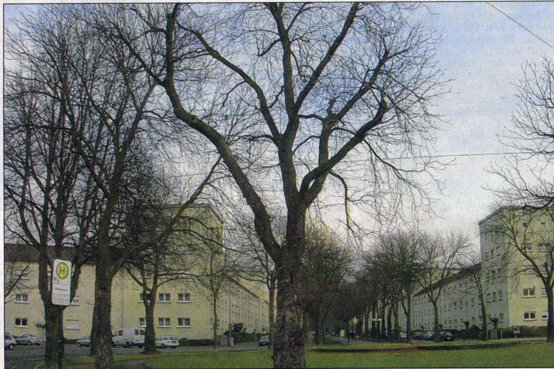
Wird in diesem Jahr modernisiert: Die dem Ebertpark zugewandte Front der Ebertsiedlung.
