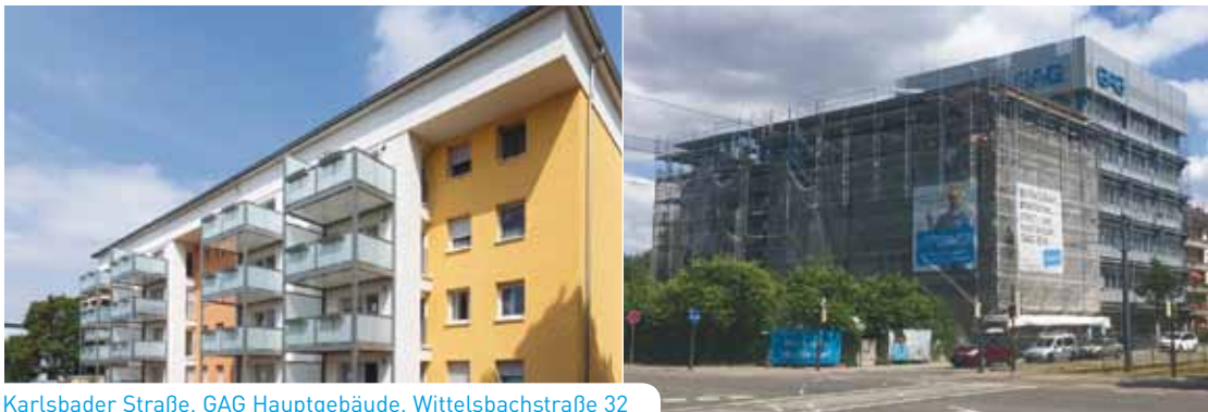
Karlsbader Straße, GAG Hauptgebäude, Wittelsbachstraße 32
