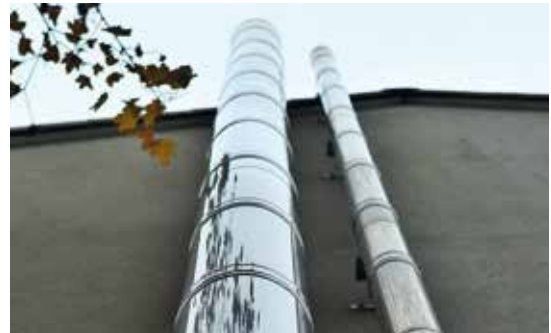
^ Zu- und Abluftrohre der BHKW-Anlage im Wohngebiet Mundenheim Süd-Ost < Passivhaus im Bestand, Hoheloogstraße
