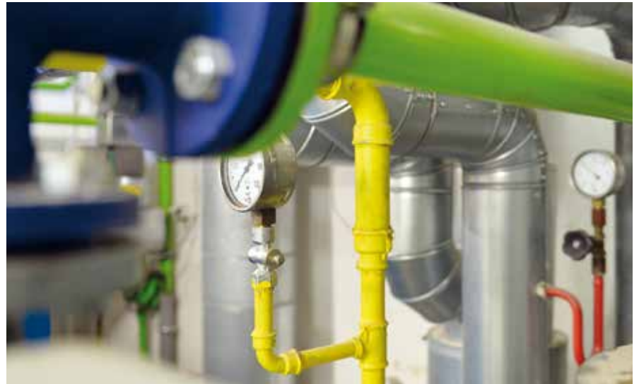
✓ Rohrleitungen der Nahwärmestation im Keller, Nordring 51, grün steht für Trinkwasser, gelb für Gas
