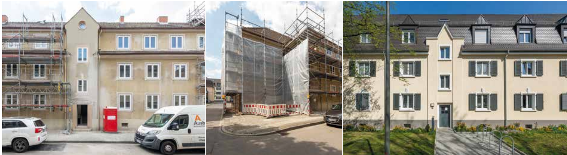
Noch stehen die Gerüste, aber bald schon glänzen die Häuser nicht nur mit neuer Fassade, wie ihre Nachbarschaft im Finkenweg 11-16.
