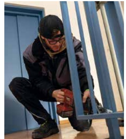
^ Metallbaumeister Martin Müller (oben) und Lehrling Jérôme Mäser bei der Demontage der alten Geländer
