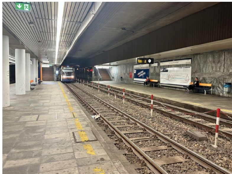
Unter dem Hauptbahnhof verlaufende Straßenbahn-Trasse.
