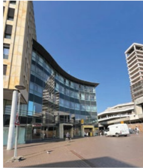
Durchgängig versiegelte Fläche im Bereich der Bismarckstraße.
