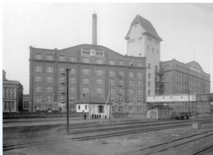
Die nach Brand und völliger Zerstörung Anfang des 20. Jahrhunderts wiedererrichtete Walzmühle mit repräsentativer Jugendstilfassade als industrielles Gegenstück zum Mannheimer Schloss.
