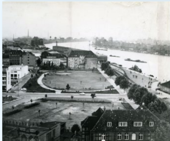
Geplantes Rathaus mit Stadthalle und Amtsviertel (oben), Realität (unten).
