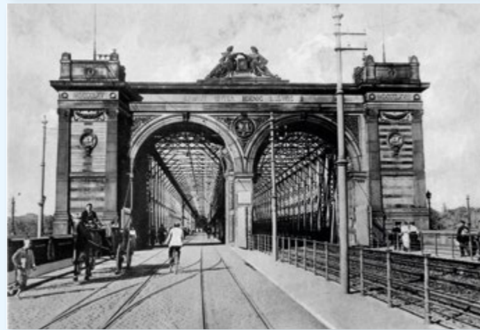
Rheinbrücke, Bau (1867) und fertige Brücke.
