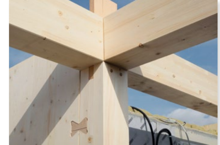
Vollholz-Knotenpunkt mit Überbrückungselement aus BauBuche.
