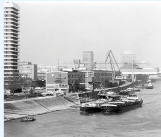
Stromhafen mit neuem Containerterminal, 1960er-Jahre (links); Neubau der vierspurigen Nord-Süd-Verbindung (unten links und rechts).
