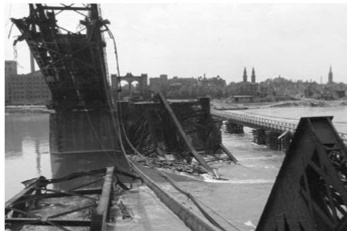
Zerstörte Rheinbrücke (1945), im Hintergrund das zerstörte Ludwigshafen.
