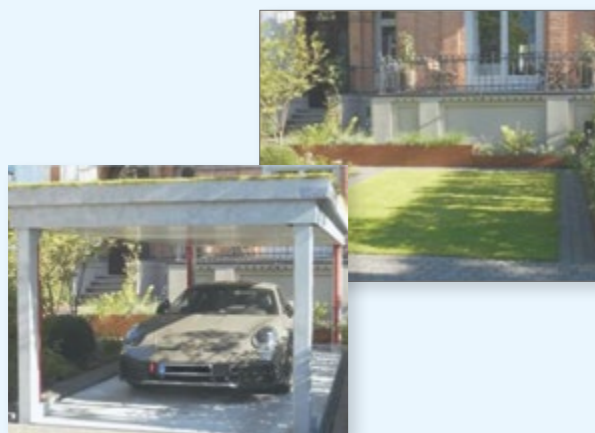
Tiefgarage mit automatischer Parkfunktion im Regalsystem.
