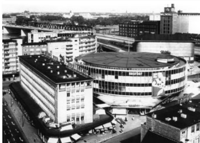
Geschäftshaus mit „Tortenschachtel“, direkt dahinter der alte Pfalzbau vor seinem Abriss.
