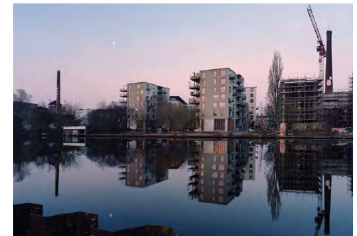
Projekt „Spreuer“ vorher und während der Bebauung. Quelle: Michael von Matuschka.
