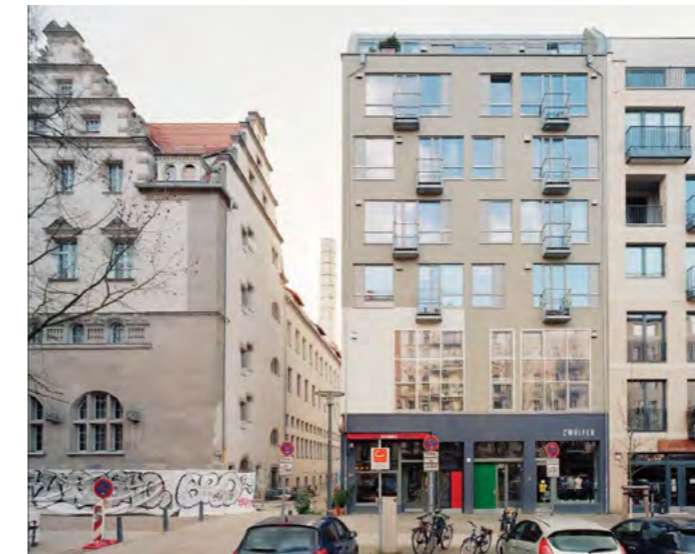
Das Berliner Stadthaus in der Oderberger Straße nach seiner Fertigstellung in 2009. Quelle: Michael von Matuschka.
